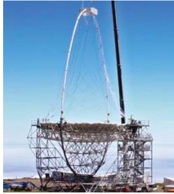
Figure 1 : Montage de l'arche du grand télescope de l'expérience CTA
