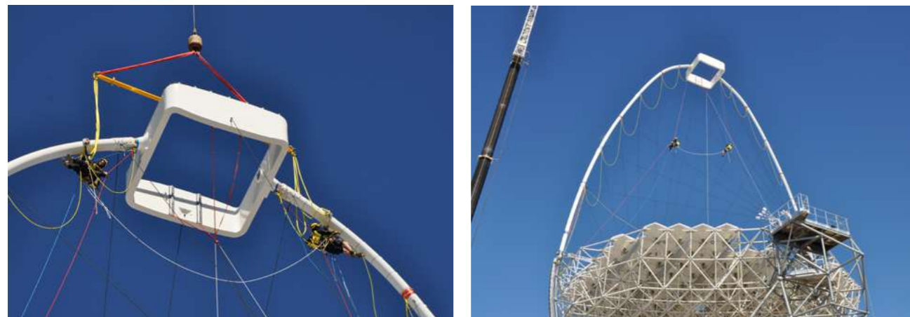
Figure 6 : Photos de l'installation de l'arche du LST prototype à La Palma.
