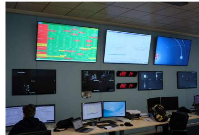
Figure 4 : Salle de contrôle de Virgo avec différents écrans de suivi du détecteur, en particulier le visionnage temps-réel des caméras numériques et l'évolution temporelle de paramètres du détecteur.
