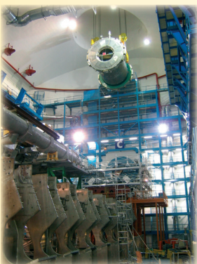
Figure 6 : Descente du cryostat tonneau (solénoïde + calorimètre électromagnétique) dans le puits ATLAS (octobre 2004)
