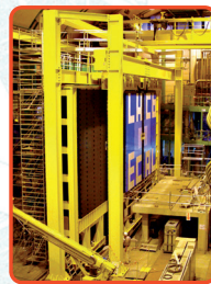
Objet réel : structures mécaniques installées dans la caverne LHCb
